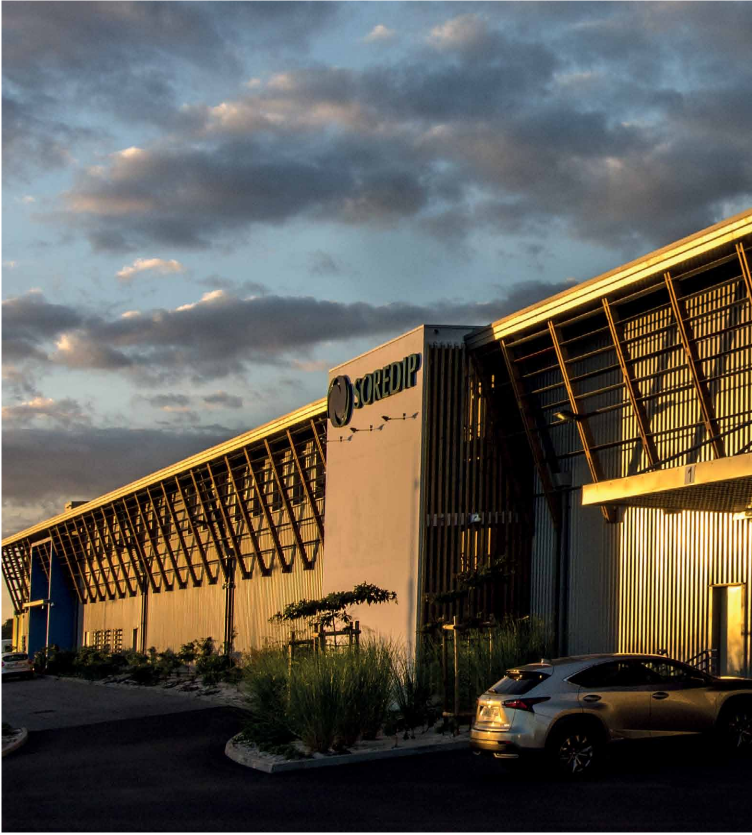
Siège et entrepôt logistique de la SOREDIP (Groupe CFAO) au Portail (Saint-Leu)
