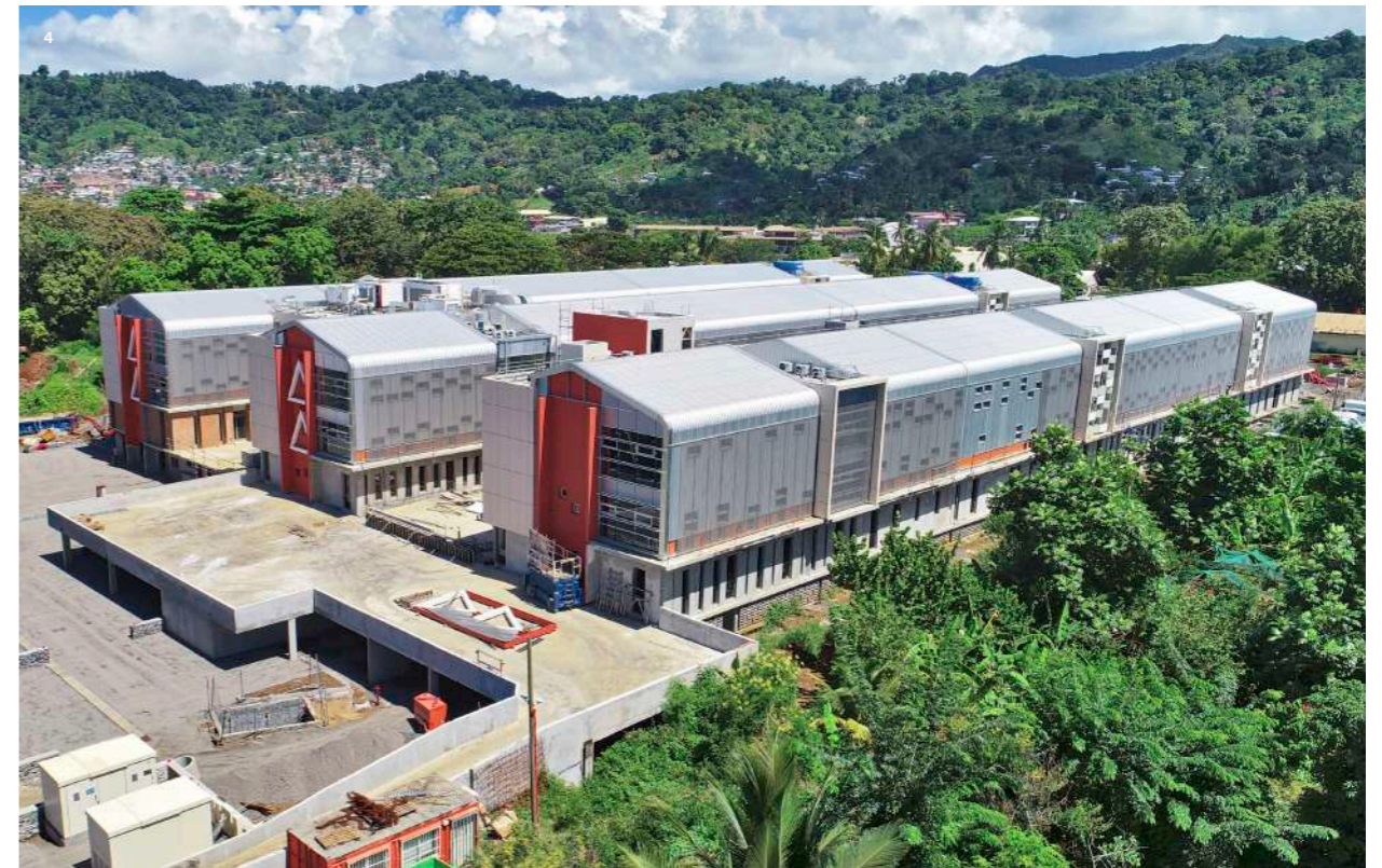
1 - Roche des sables - Roche-Café ( Saint-Leu) 2 - Zone commerciale du Sacré Coeur (Le Port) 3 - Beauséjour (Sainte-Marie) 4 - Centre d'affaires Kawéni (Mamoudzou, Mayotte)
